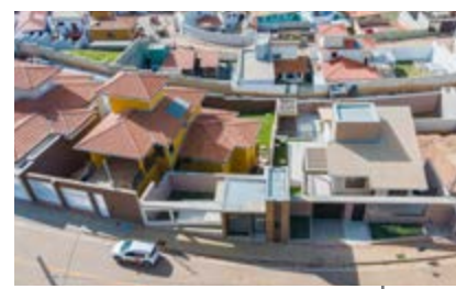
Novo distrito Bento Rodrigues - Minas Gerais State
