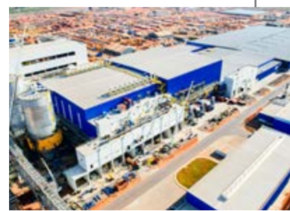
New Suzano Factory in Ribas do Rio Pardo - Mato Grosso do Sul State
